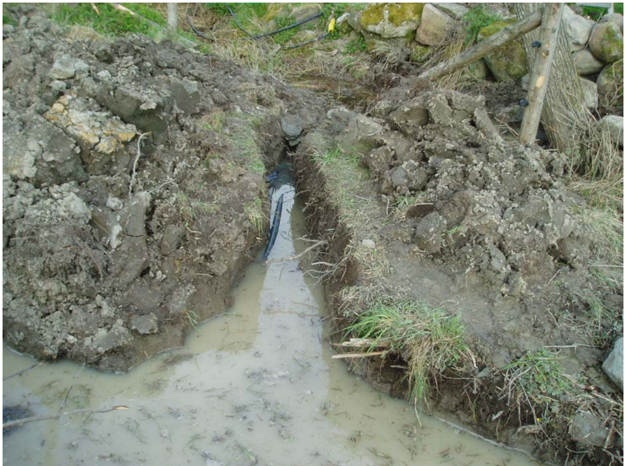
Bild 43. Schakt på Matning in till kopplings skåp nere vid vägen 4:19
