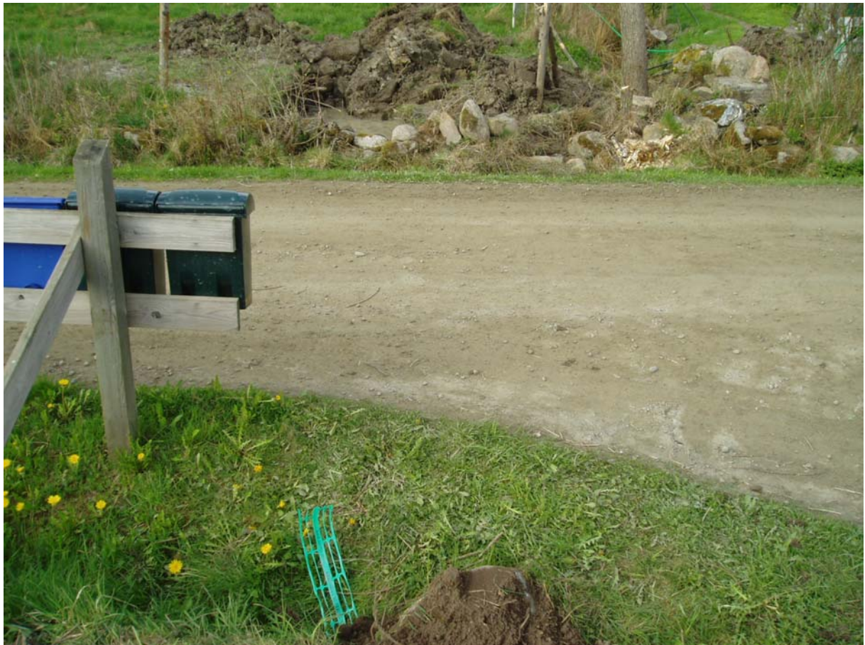
Bild 44. Visar schakt under väg matning från kopplings skåp vid 4:19 till 4:6 o bortåt. Märkband slutar här
