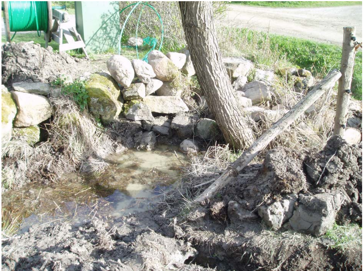
Bild 42. Kopplings skåp nere vid vägen. Tuber lagda under utfallsdike.
