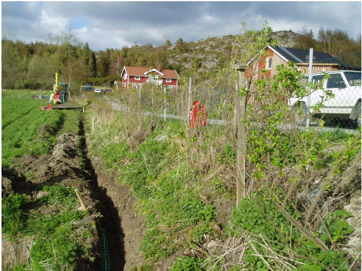
Bild 51. Schakt vidare mot skarv 1 tub till 4 tub utanför 4:6
