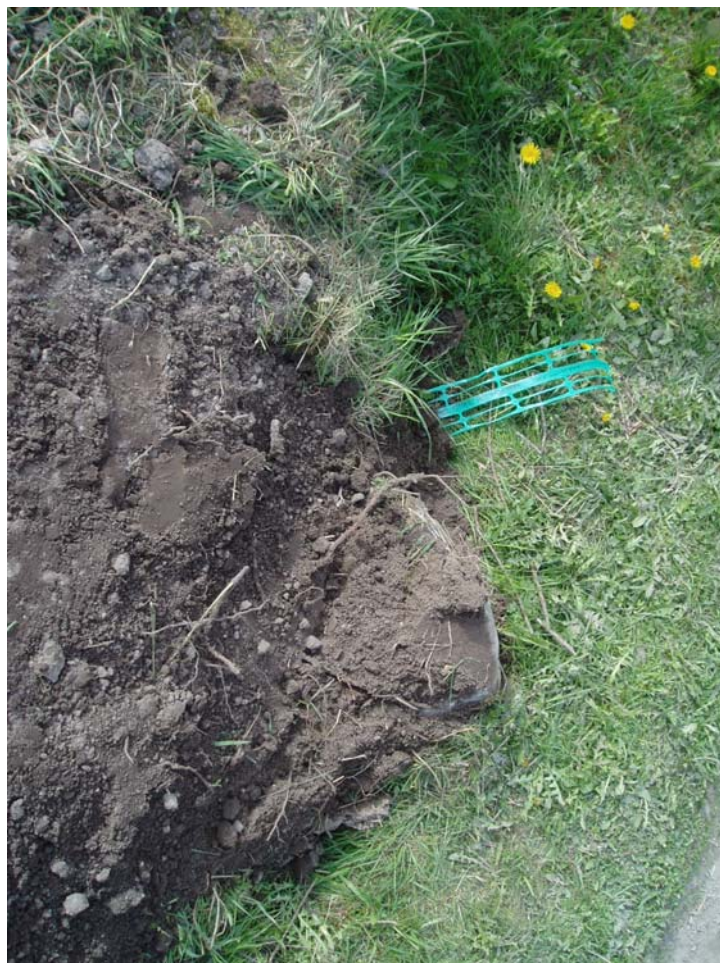
Bild 45. Visar schakt under väg matning från kopplings skåp vid 4:19 till 4:6 o bortåt
