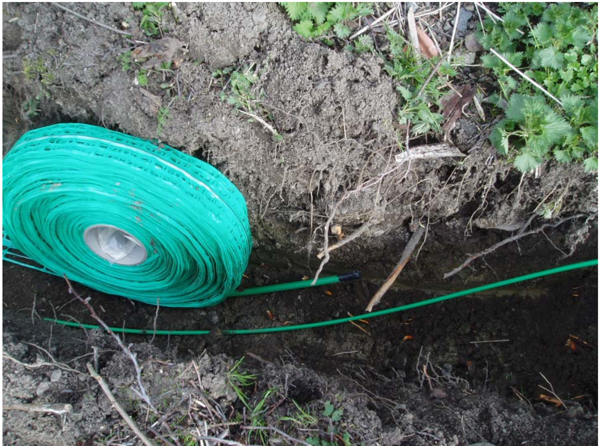
Bild 52. Skarvplats vid skarv 1 tub till 4 tub utanför 4:6
