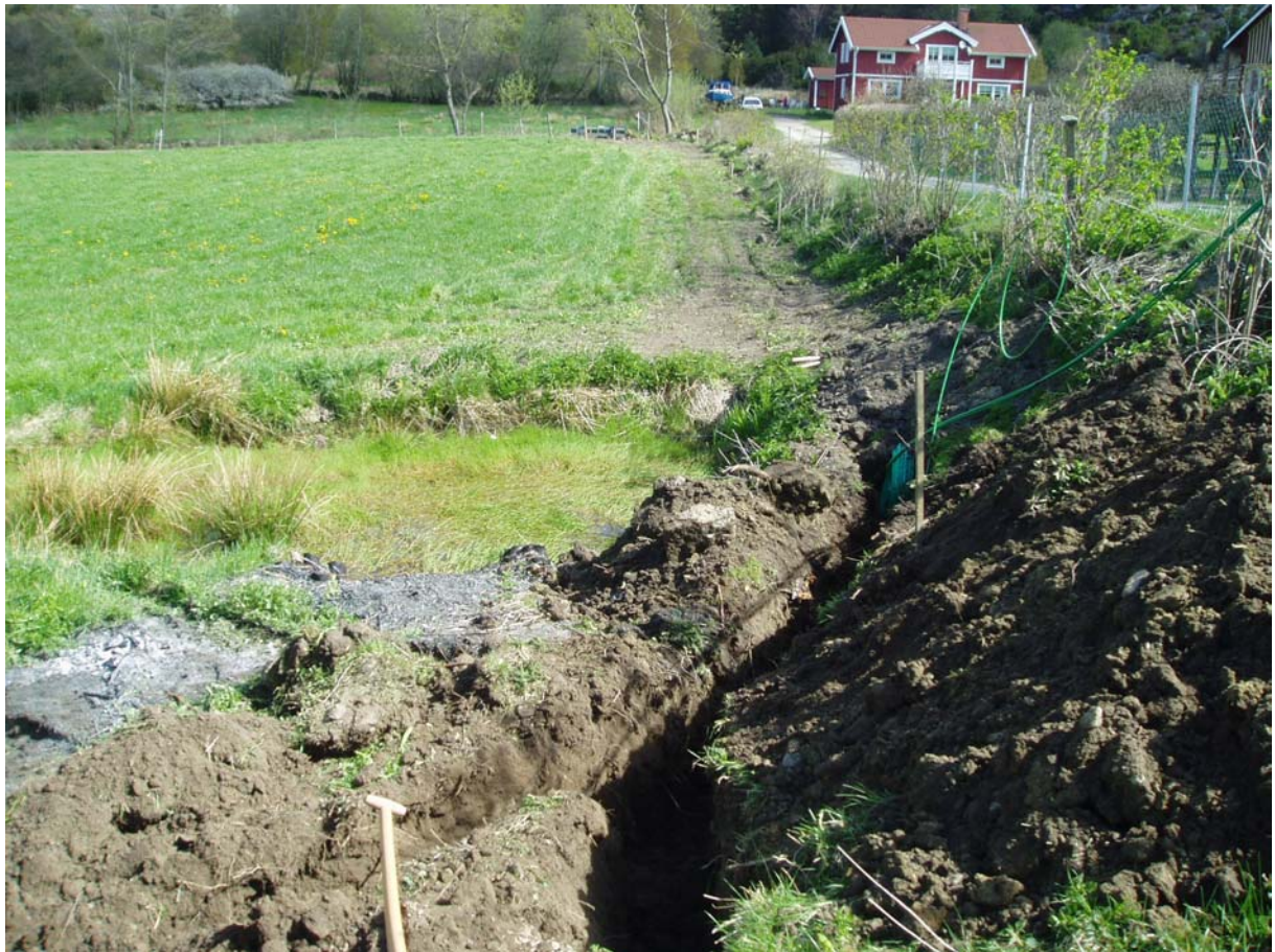
Bild 55. Från skarv 1 tub till 4 tub utanför 4:6 mot fastighet 4:6 och bort mot 4:7
