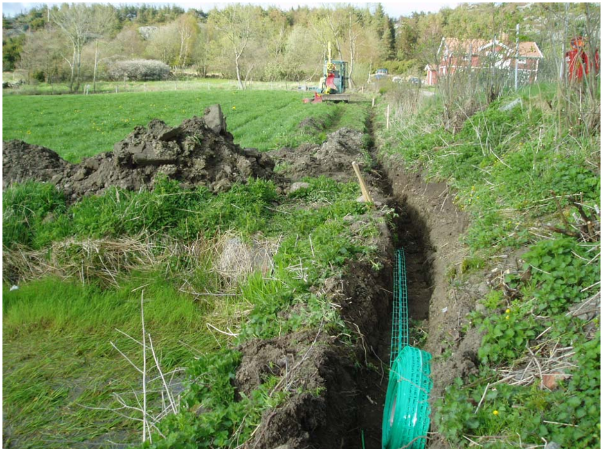
Bild 50. Schakt vidare mot skarv 1 tub till 4 tub utanför 4:6 runt damm.
